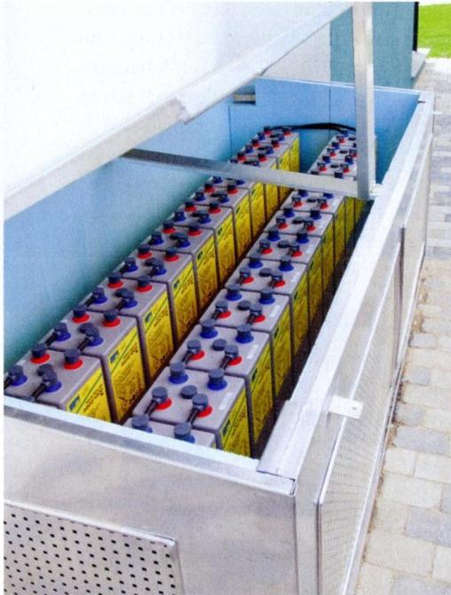
Die Bleiakkus mit einer Kapazität von zusammen 48 Kilowattstunden sind außerhalb des Hauses deponiert. Das erhöht die Haltbarkeit.
